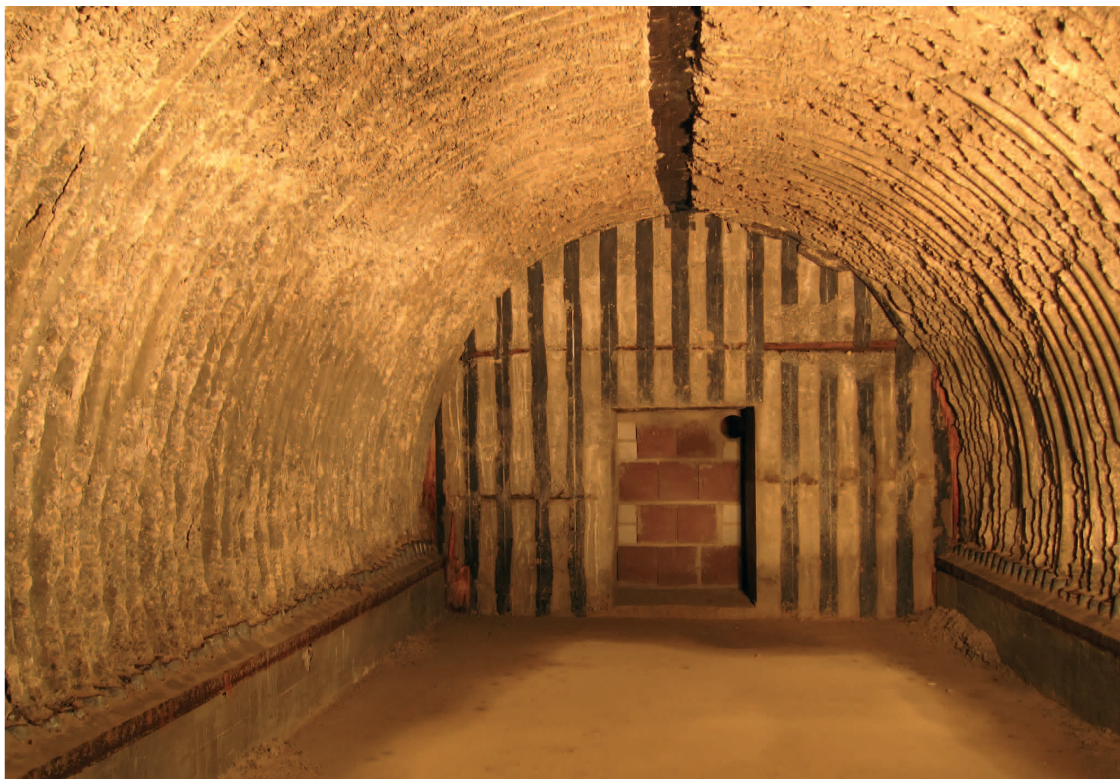
Einer der beiden Haupträume der Sanitätsbunkeranlage ca. 5 Meter unter den Reben des Tunibergs
